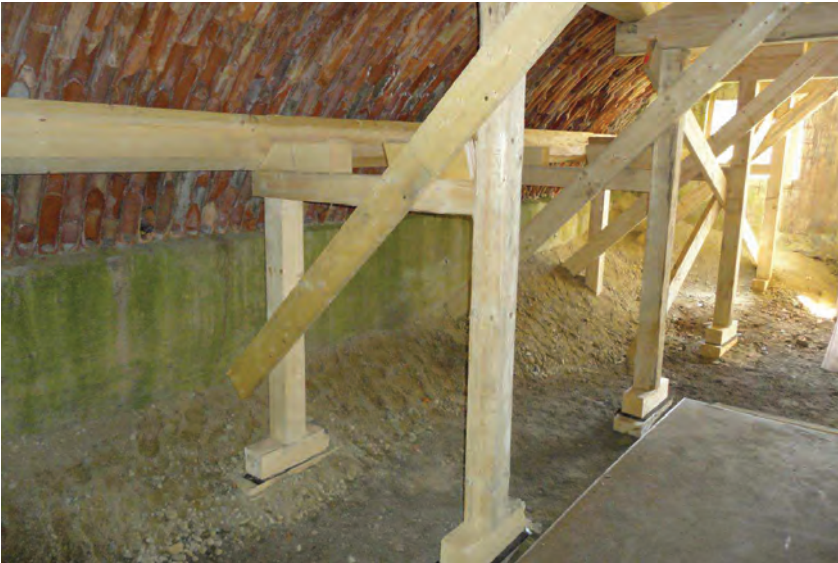
1. Kiesanschüttung an ausgebrochenen Fundamentbereichen als statische Sicherung
