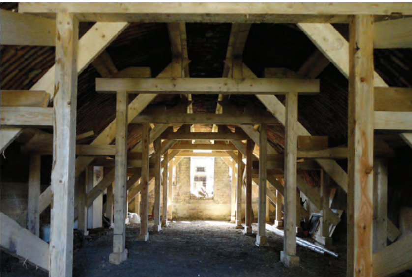
2. Eingebaute Notsicherung als Holzkonstruktion
