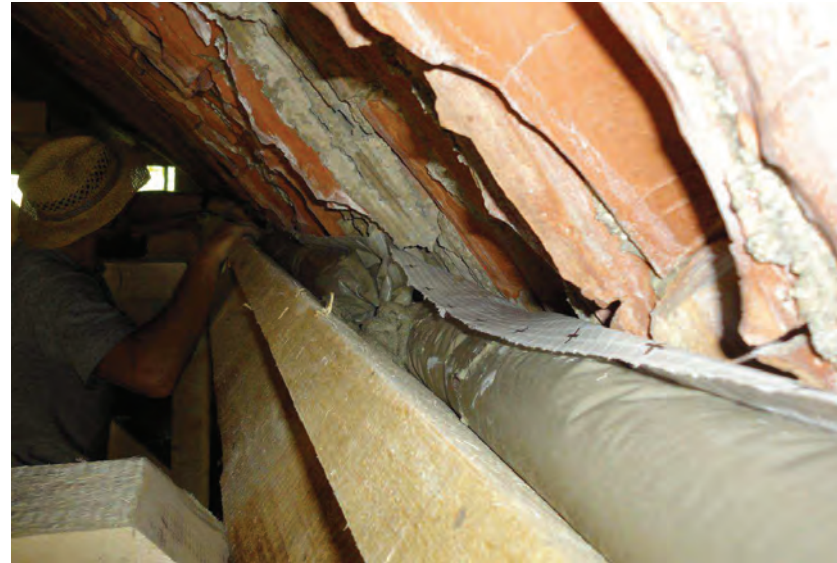
3. In Kunststoffschläuche gefüllter Mörtel wird an die Geometrie der teils geschädigten Tonröhren angepasst (vor Erhärtung). Unterkonstruktion ist die auf Abstand eingebaute Holzkonstruktion.
