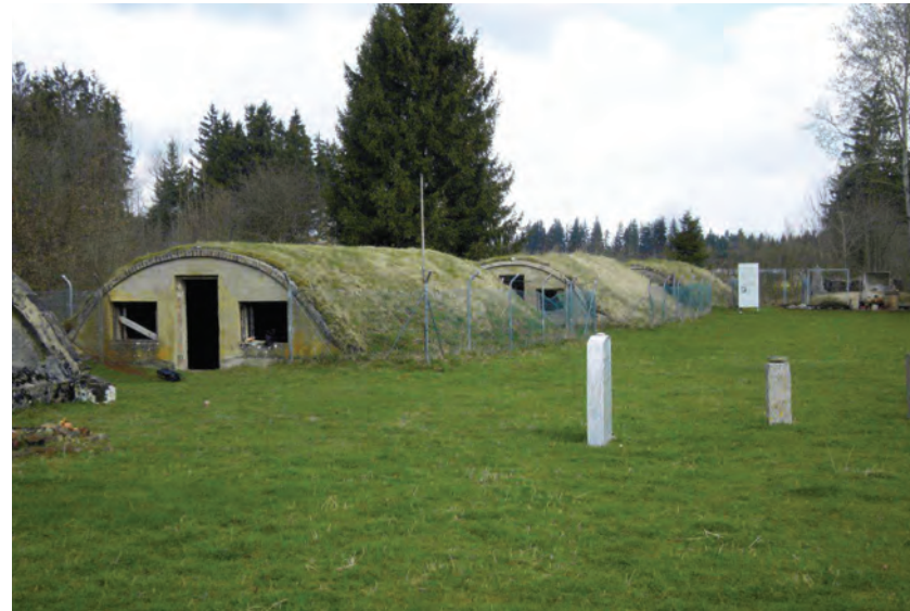
2: Bauwerk 4 mit Umgriff (im Hintergrund Bauwerk 3 und 2).
