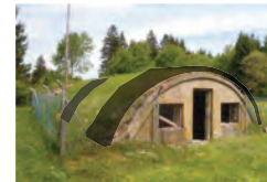
Additive Betonschale in den stark geschädigten Bereichen und Sicherung der Tonröhren
