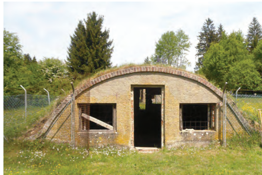
4: Stirnseite von Bauwerk 4, Südansicht.
