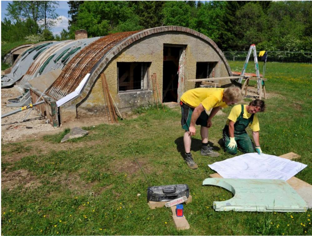
Die Konservierungsarbeiten an dem ersten von drei Tonröhrenbunkern gehen planmäßig voran. Derzeit wird von Simon Laure und Jan Hiekl (von links) die Armierung für die Betonstreifen über die halbrunden Dächer gelegt. Foto: Thorsten Jordan
