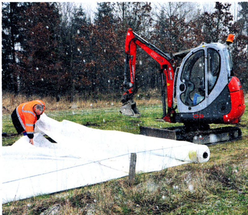
Der Chef persönlich legte gestern Hand an: Markus Heindl vom gleichnamigen Bauunternehmen verlegte das Geotextil, auf das dann eine Kiesschicht als Zufahrt zum KZ-Außenlager Kaufering VII kam. Foto: Thorsten Jordan
